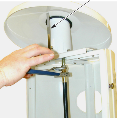
Figura 13 - Instalación del conjunto de manguera y regulador
